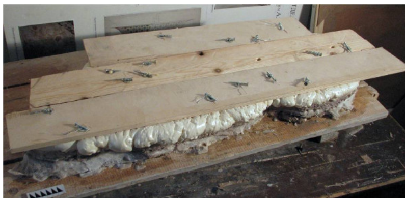
Рис. 3 Фиксация армирующего деревянного щита. Авторский снимок
